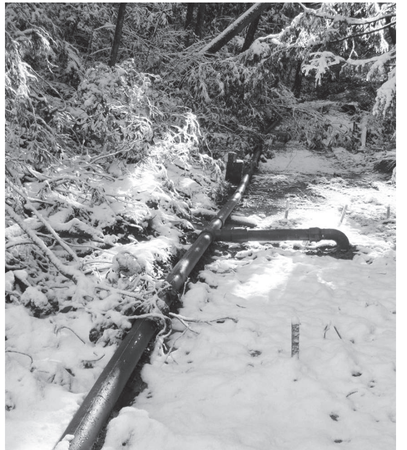
新しく水道管を敷設しました。
