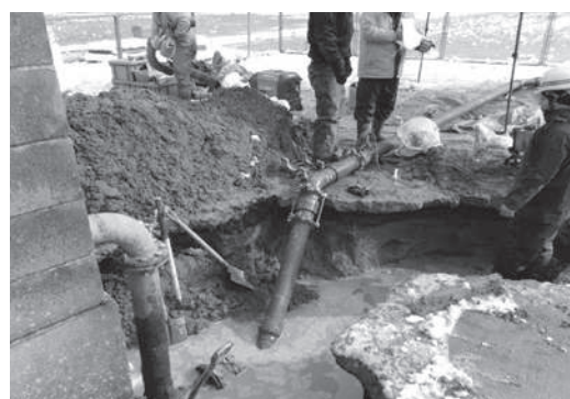
赤浦1号井戸の水道管敷設作業の様子
