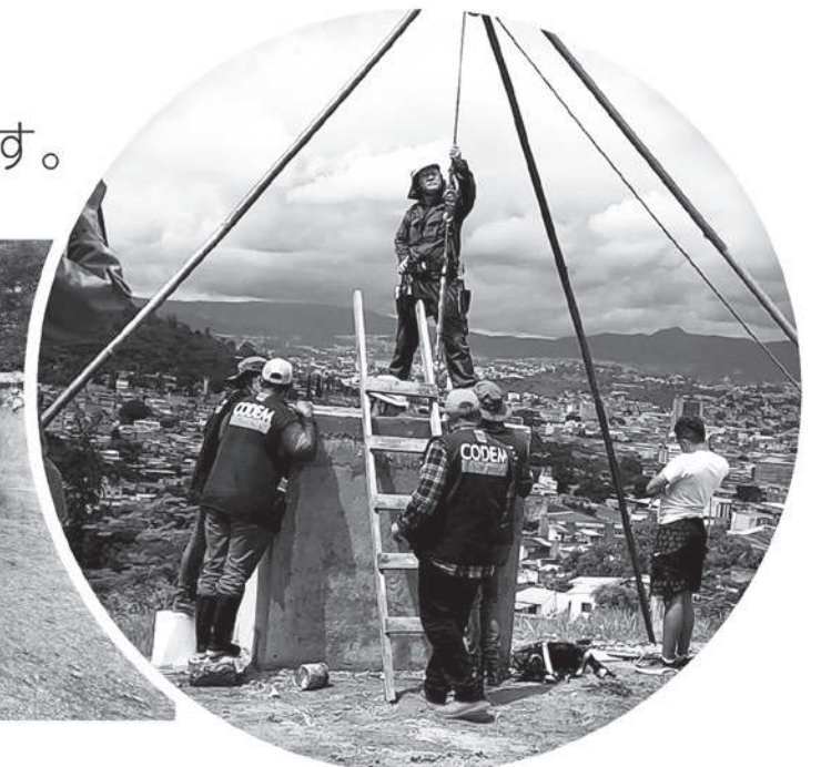
多段式傾斜計の設置風景
