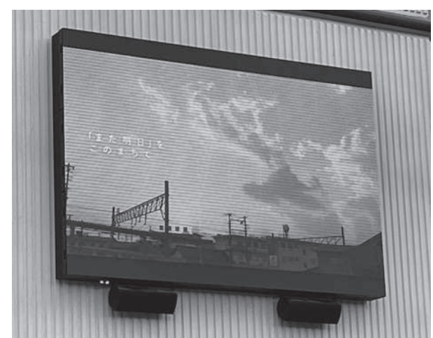
パトリアビルに設置されたモニター
