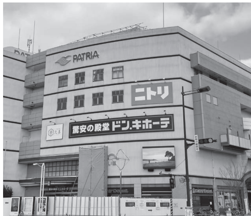
パトリアビルに設置されたモニター
